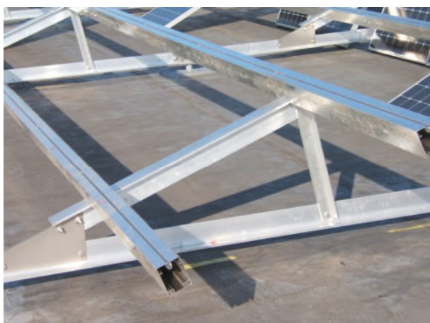
Bild 3 Aufständerdreieck mit Winkeln
