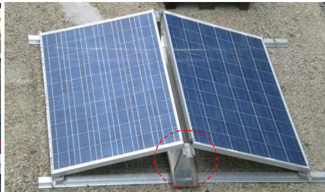
Bild 20 ballastarmes System Ost-West-Aufständigung
